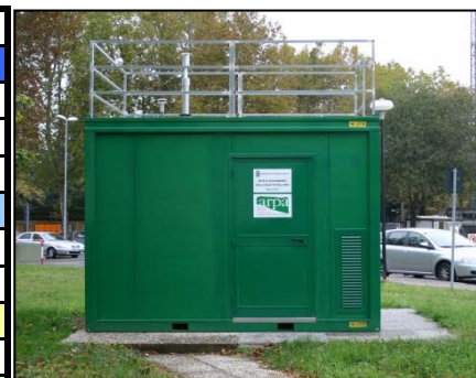
Stazione di monitoraggio della qualità dell'aria
