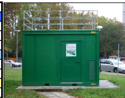
Stazione di monitoraggio della qualità dell'aria
