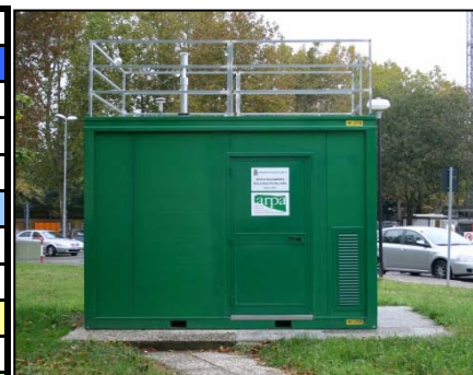
Stazione di monitoraggio della qualità dell'aria
