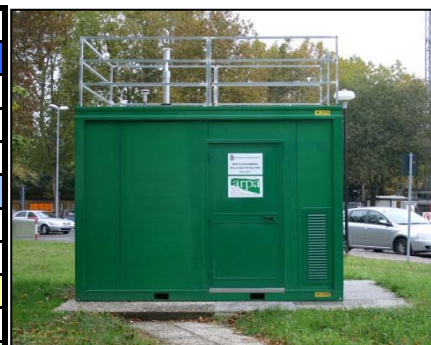
Stazione di monitoraggio della qualità dell'aria
