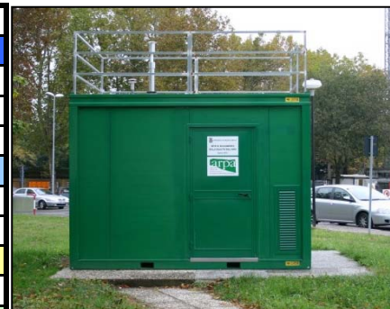
Stazione di monitoraggio della qualità dell'aria
