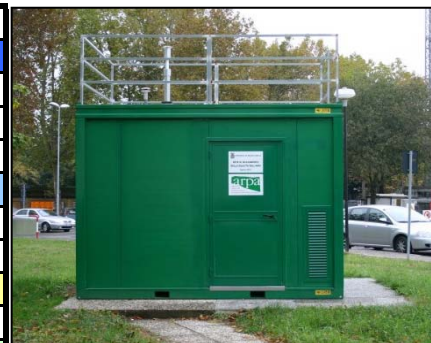
Stazione di monitoraggio della qualità dell'aria
