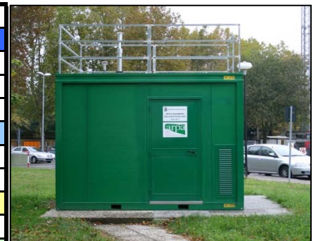
Stazione di monitoraggio della qualità dell'aria
