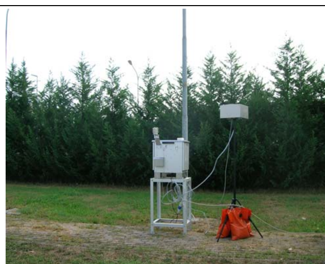
Foto.2: collocazione dell'unità mobile Skypost
