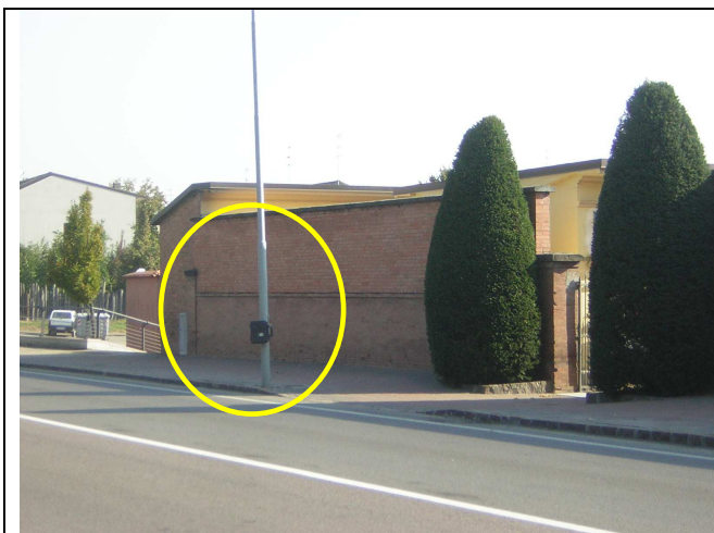
Foto.1: Contatraffico su via Vandelli
