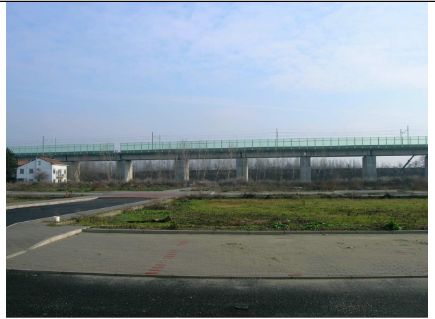
Viadotto e linea ferroviaria raddoppiata vista di fronte al punto P2
