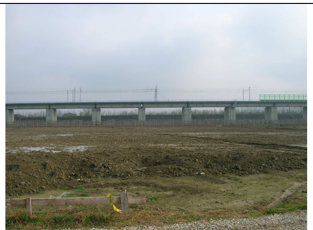
Viadotto e linea ferroviaria raddoppiata vista di fronte al punto P1
