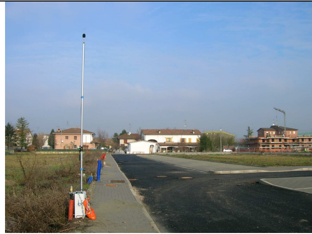
Centralina di misura nel punto P2
