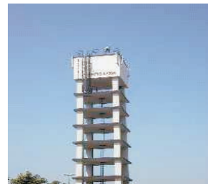
Impianto SRB VODAFONE 1496A P.zza De Cristoforis
