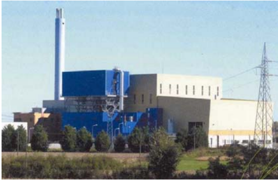
Figura 7: Impianto di termovalorizzazione di Piacenza
