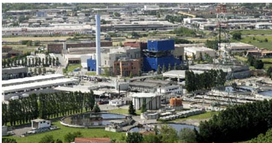
Figura 24: Centro servizi di Borgoforte in cui è collocato l'impianto Tecnoborgo (Fonte: Iren Emilia)
