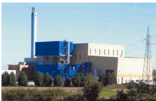
Figura 11: Impianto di termovalorizzazione di Piacenza
